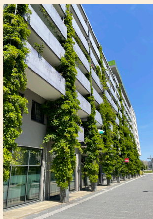
4.42 Klimmend groen aan de constructie
