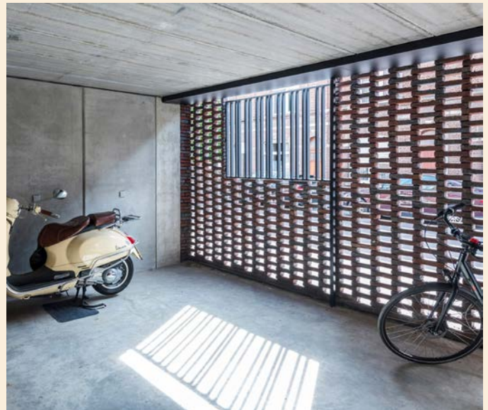
5.12 Opengewerkt metselwerk bij fietsenstalling op zicht tussen binnen en buiten te behouden en een gedetailleerde gevel te hebben voor een aangename straatbeleving
