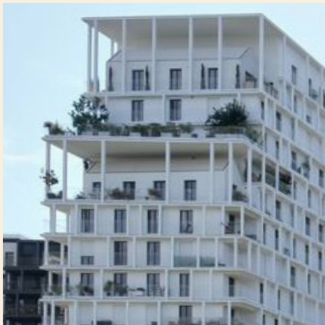
4.48 Geraamte van balkons; installatie dak uit het zicht en integraal mee-ontworpen
