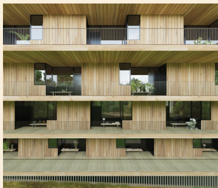
4.29 Gebeitst houten panelen
