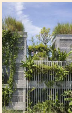
4.37 Groene planten aan de gevel
